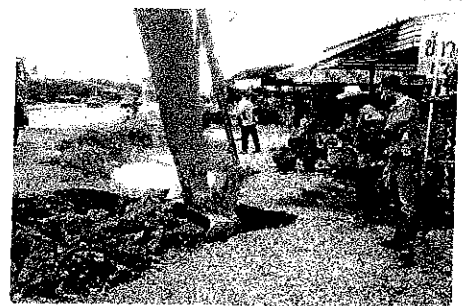
วันที่ 5 กันยายน 2561 งานแก้ไขน้ำท่วมบริเวณหมู่บ้านหนองน้ำขาว พื้นที่หมู่ที่ ๑ โดยการรื้อแนวท่อเดิมออกแล้ววางใหม่
